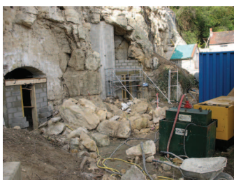
Confortement de falaises à Chars (95)
